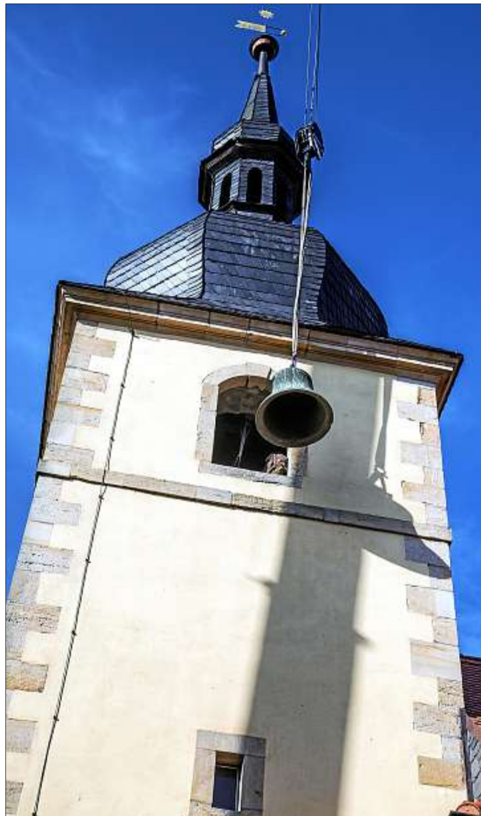
Mit einem Kran wurde die Glocke aus dem Kirchturm herausgehoben. Sie stammt aus dem Jahr 1575 und wiegt zwischen 450 und 500 Kilogramm. Fotos: Paul-Philipp Braun
